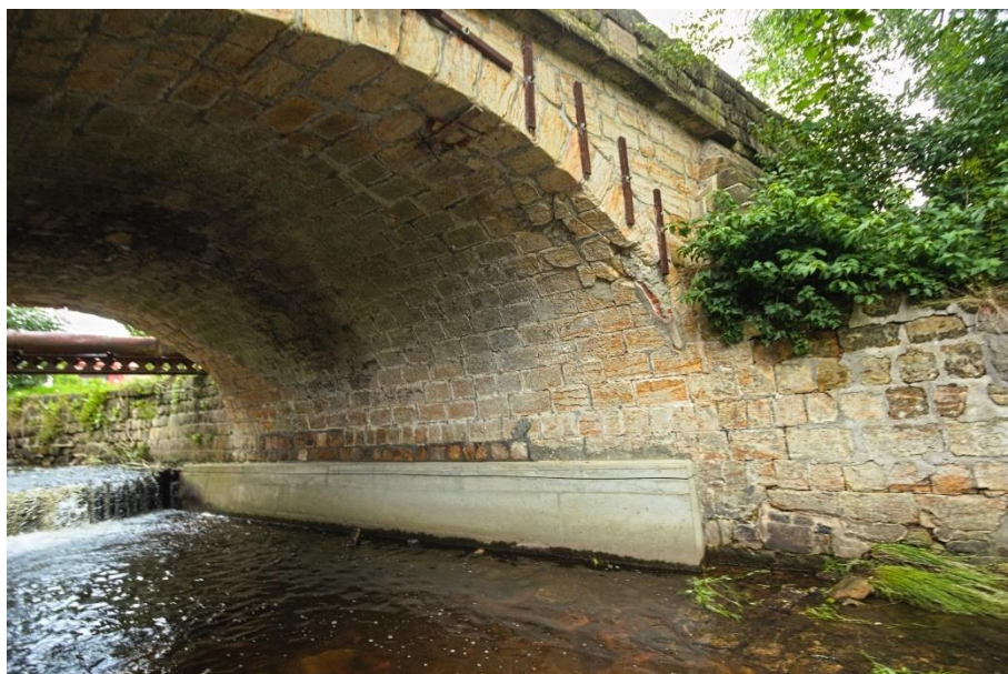
Obrázek 6 Pohled na levobřežní opěru mostu s betonovou předpatkou
