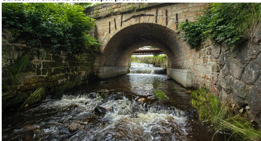
Obrázek 5 Celkový pohled na most proti proudu. V popředí patrné pozůstatky dlažby ve dně tvořící přelivnou hranu odtékající vody z výmolu pod mostem.
