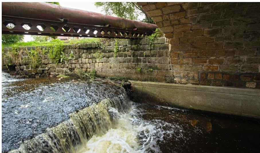
Obrázek 1 Levý břeh nad mostem, pohled proti proudu. Zdivo s narušenou stabilitou vlivem zemních tlaku a hydraulickým namáháním na vnější straně oblouku.
