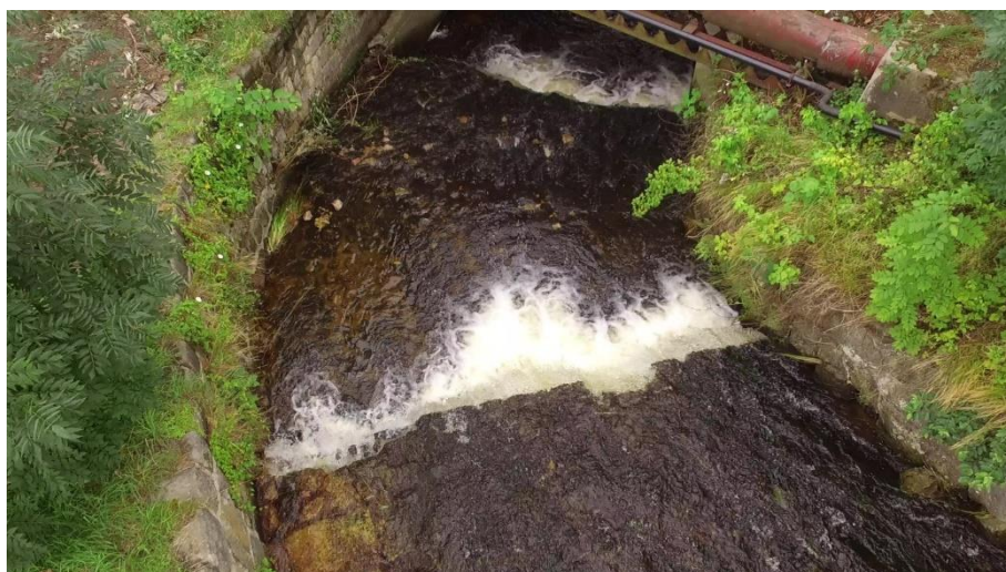
Obrázek 3 Celkový pohled na oba stupně. Na horním stupni je viditelné poškození přelivné hrany.
