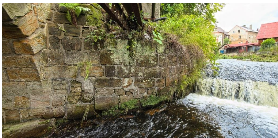
Obrázek 2 Navázání mostu na pobřežní zed' na pravém břehu nad mostem
